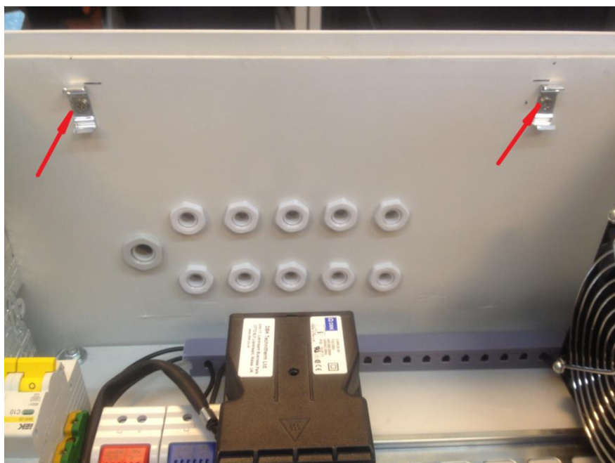
Рис.3.2.2-1 Установка пружинных креплений шкафа OSP.
