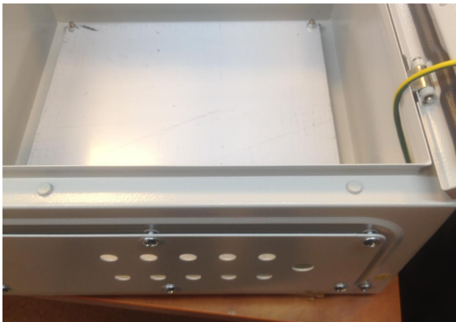
Рис.3.1.2-1 Резиновые заглушки установленные в монтажные отверстия шкафа OS.
